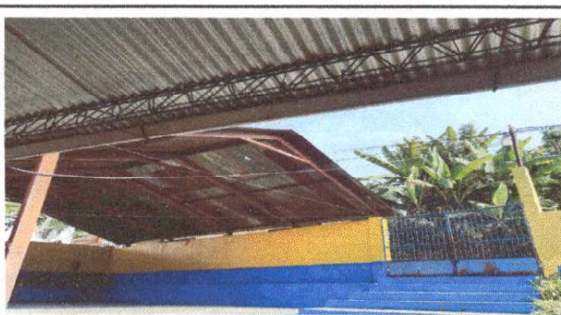
Foto 6: Sustitución de canal de metal Y Sustitución de bajada de agua pluvial de metal por tubo PVC 3"
