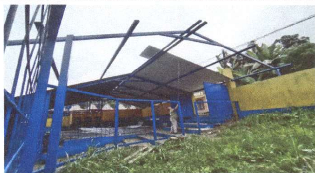
Foto 1: CUBIERTA DE LAMINA Y ESTRUCTURA DE TECHO
