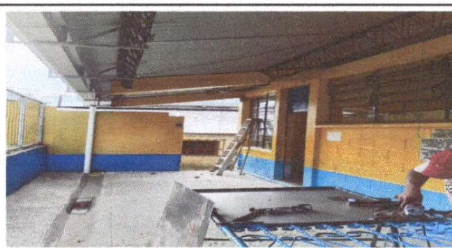
Foto 5: Sustitución de BAJANTE
