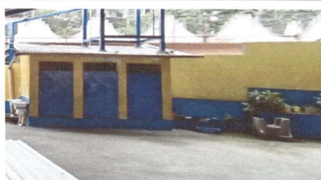
Foto 2: Sustitución de puerta en servicios sanitarios
