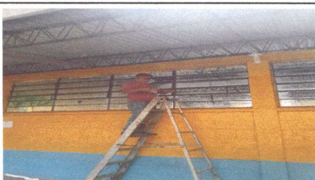
Foto 4: Sustitución de VIDRIOS
